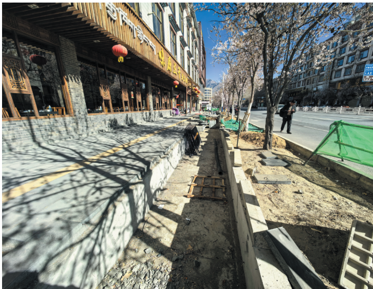
图为色拉路水系工程开挖的明渠。拉萨融媒记者 小拉姆次仁摄
