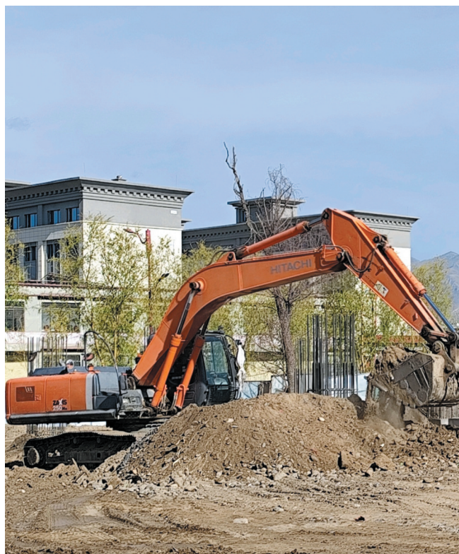
图为西藏特色农畜产品交易市场冷库建设项目施工现场挖掘
