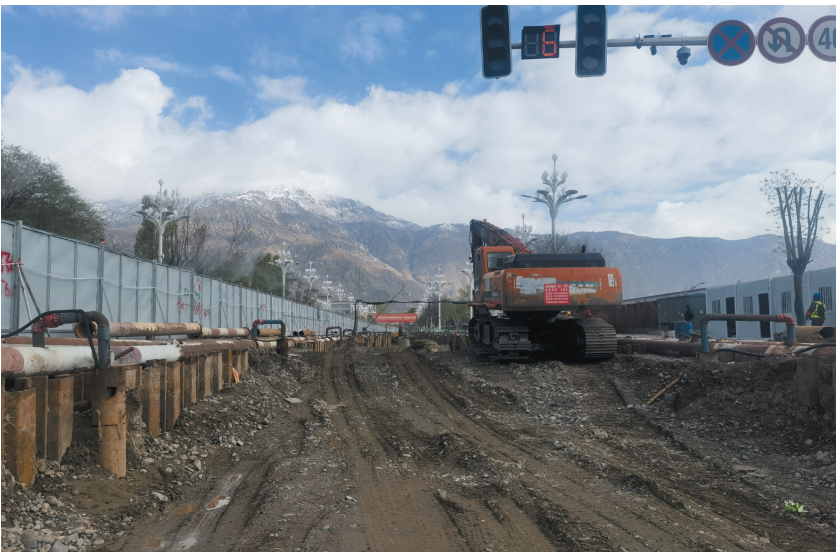
图为鲁定路、当热路优化改造工程一标段施工现场。
