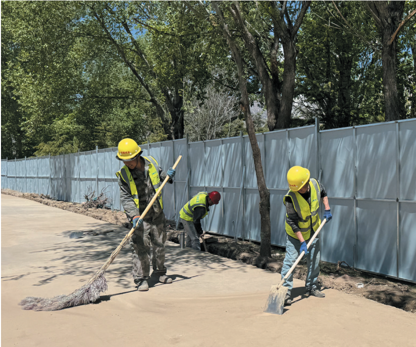
图为施工人员在施工现场进行施工。
