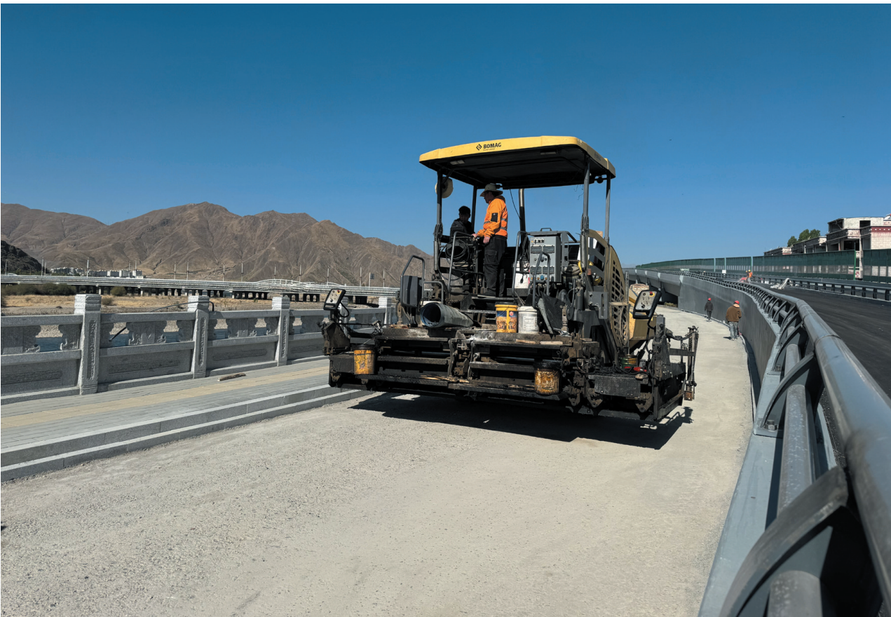
图为工人正在进行沥青下面层铺设作业。
