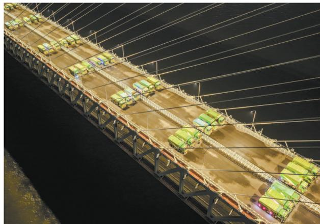
6月20日晚，常泰长江大桥主航道桥进行4400吨荷载试验，110辆重型卡车驶上主航道桥面，启动静态荷载试验。自6月16日起，常泰长江大桥开启为期一周的荷载试验，对大桥承载力和安全性进行全面评估。
