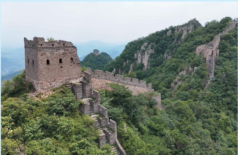
2025年6月13日拍摄的河北省秦皇岛市海港区板厂峪长城(无人机照片)。 新华社记者 杨世尧摄
