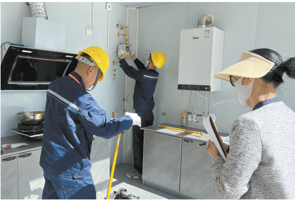
图为参赛人员进行室内安装环节比拼。拉萨融媒记者 满文妍摄
